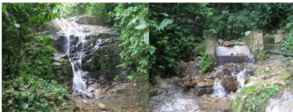
Figura 15.- Captación de Agua para Uso Doméstico Birón
