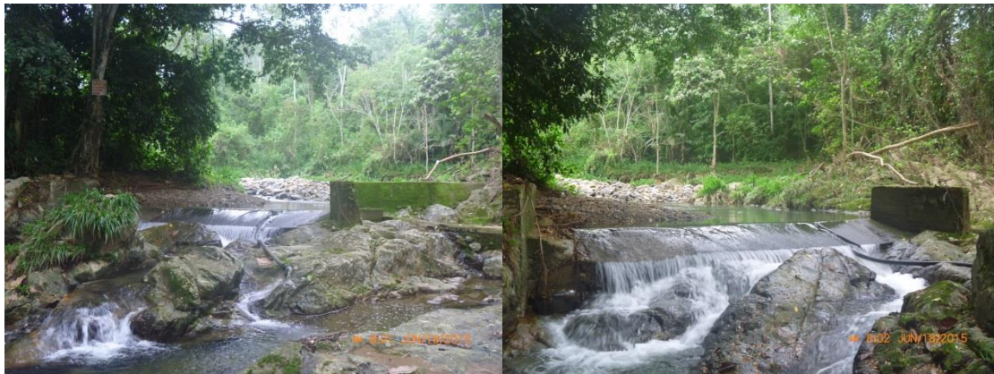
Figura 19.- Captación de Agua para Uso Doméstico Río Chico y Estero Medina.
