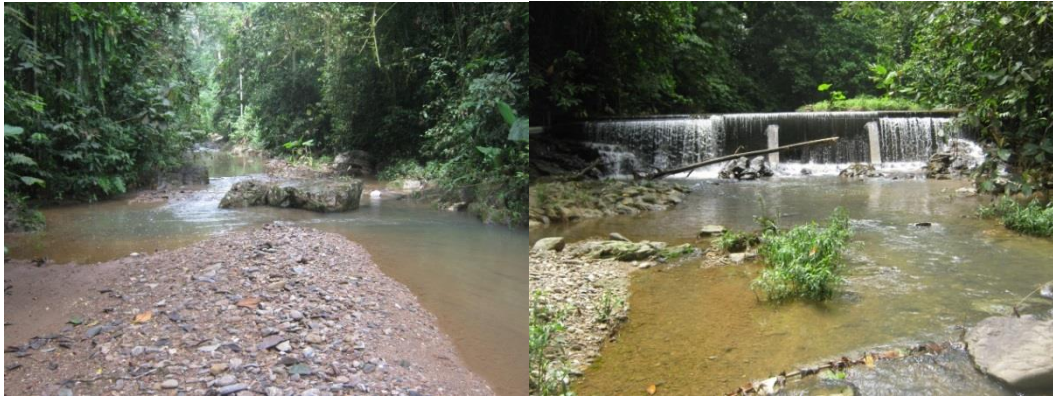
Figura 13.- Captación de Agua para Uso Doméstico Bellamaría. Fuente: Equipo Consultor PDyOT
