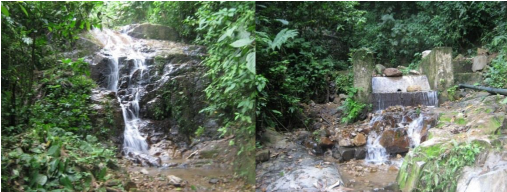
Figura 15.- Captación de Agua para Uso Doméstico Birón
