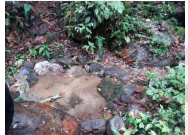
Imagen 2.1.13: Vertedero de piedra y sacos de arena artesanal de captación 2, Quebrada S/N 2 sitio San Carlos
