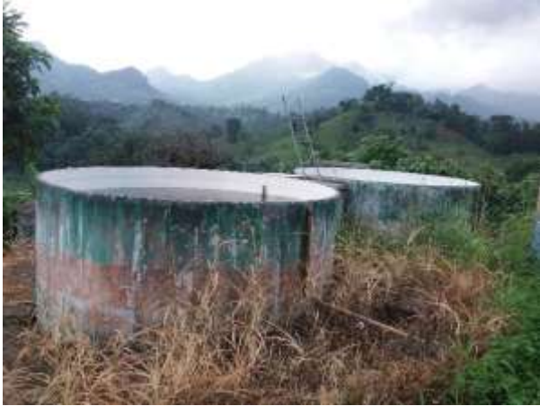
Imagen 2.1.19: Tanques de filtración del agua captada de Birón
