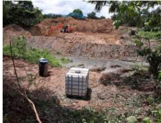
Imagen 2.1.1: Retroexcavadoras remediando los daños causados por minería ilícita en Río Chico.
